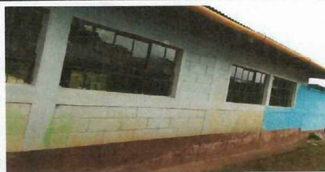
Foto 3: Cambio de los vidrios y pinturas.
