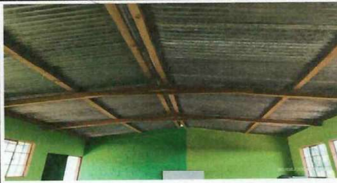
Foto 2: Cambio de maderas a costaneras.
