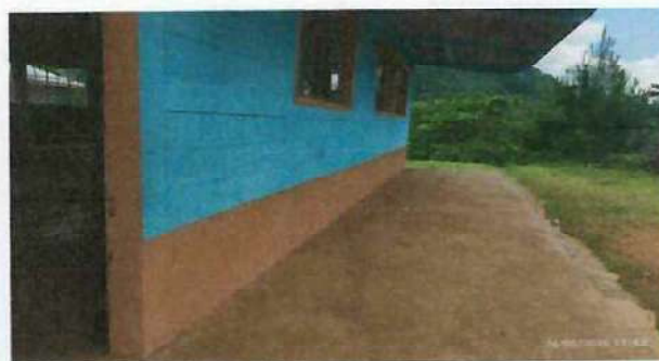
Foto 4: Cambio de piso a piso ceramica.
